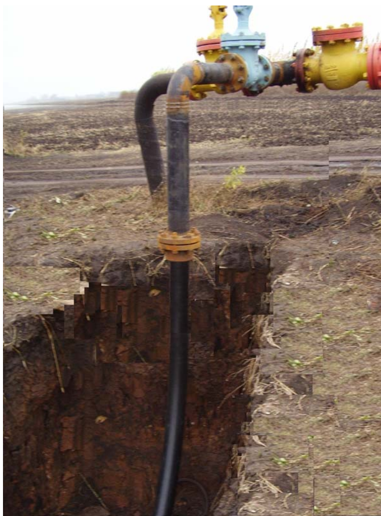
Рис.4 – Фланцевое соединение выкидного трубопровода из ПАСНТ
