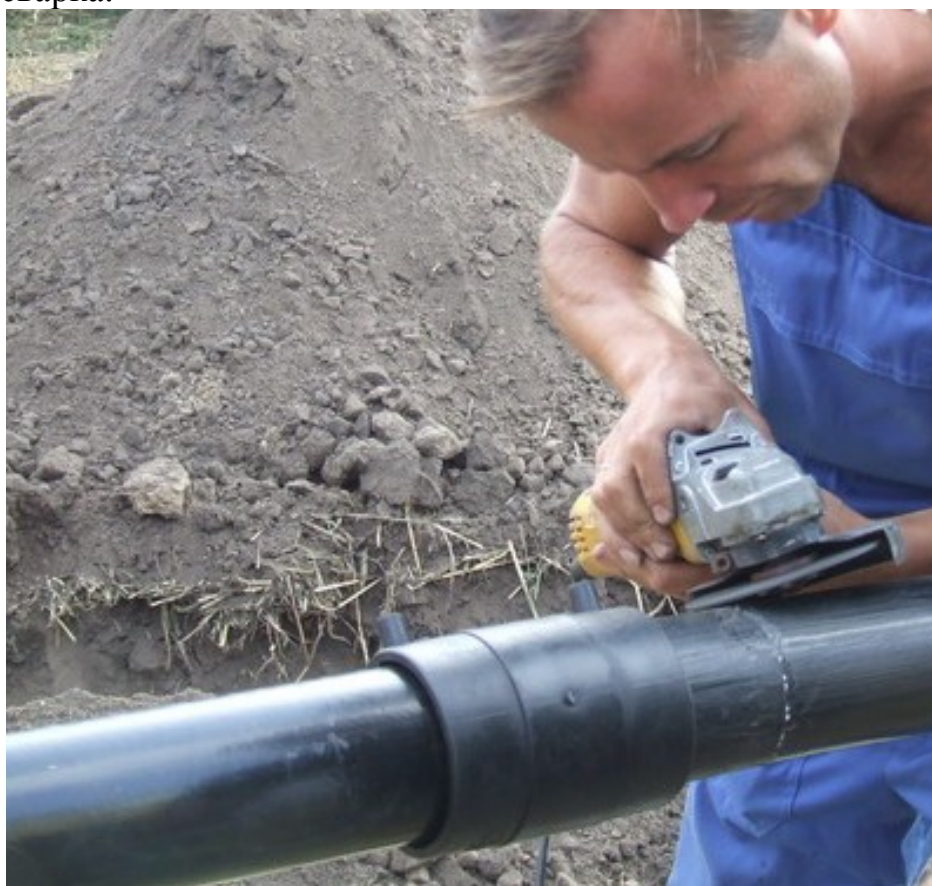
Рис.3 – Подготовка поверхности трубы под сварку муфтой с закладным нагревателем в полевых условиях
