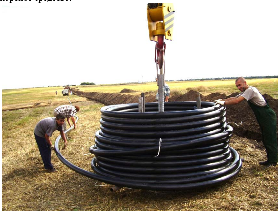
Рис.1 –Размотка ПАСНТ из бухты для монтажа выкидного трубопровода
