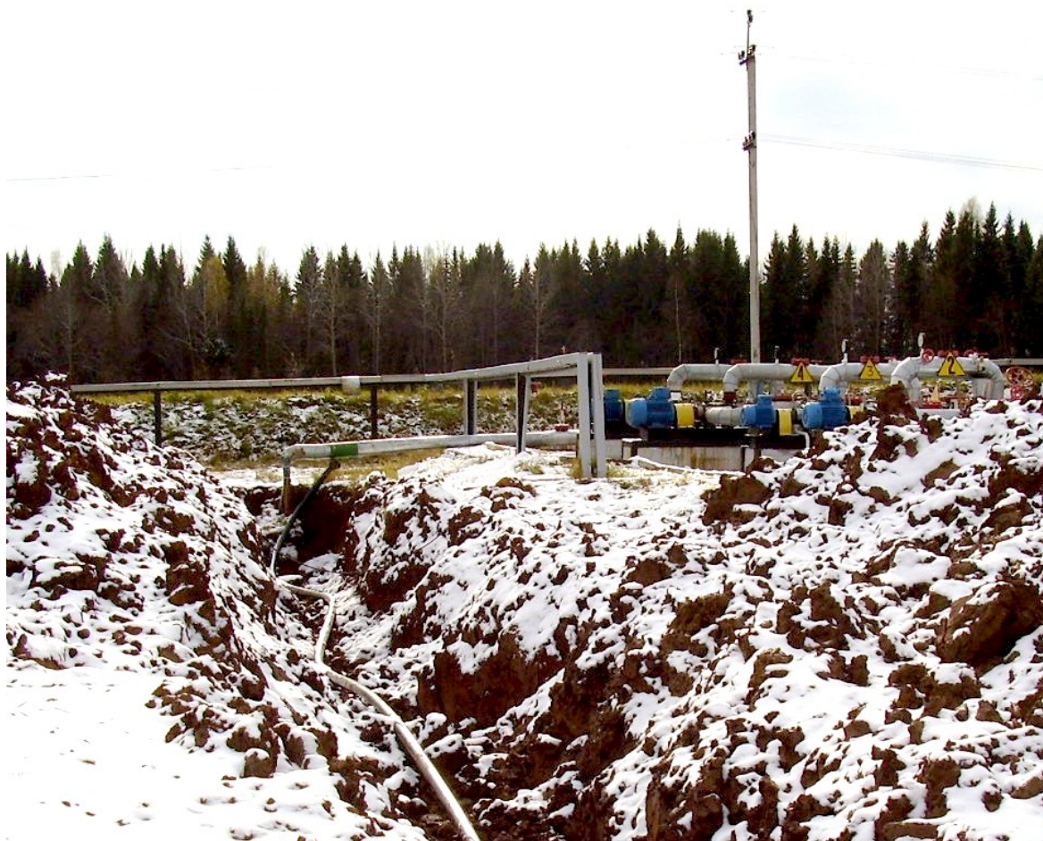
Рис.3 Строительство технологического водовода на Майкорском месторождении (Пермский край), ноябрь 2006 г.
