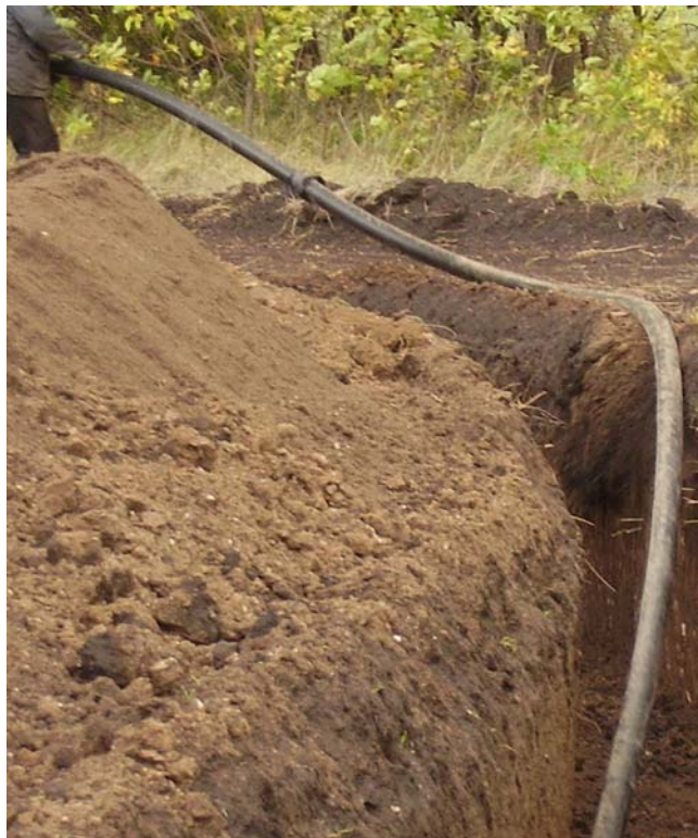
Рис. 5 Укладка выкидного нефтепровода на Глазуновском месторождении (Саратовская обл.) июль 2006 г.
