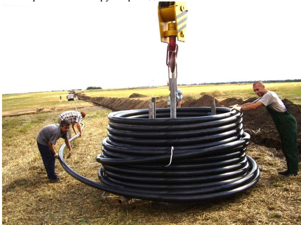
Рис.4 Размотка бухты ПАСТ при строительстве выкидного нефтепровода на Лебяковском месторождении г. Прилуки (Украина), сентябрь 2007 г.
